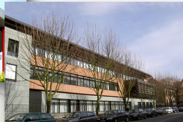
Chantier : Collège Châtelet Douai Architecte: Cabinet Boyeldieu Lille Maître d'ouvrage: Conseil général du Nord.
