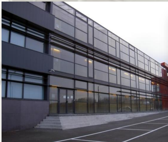
Chantier : Ilis et Ru - Loos les Lille Architecte: Cabinet Delemazure Lille Maître d'ouvrage: Académie de Lille
